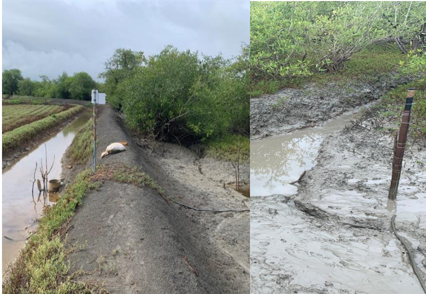
Figura 7. Aparelhos e sensores da medição do nível da água
