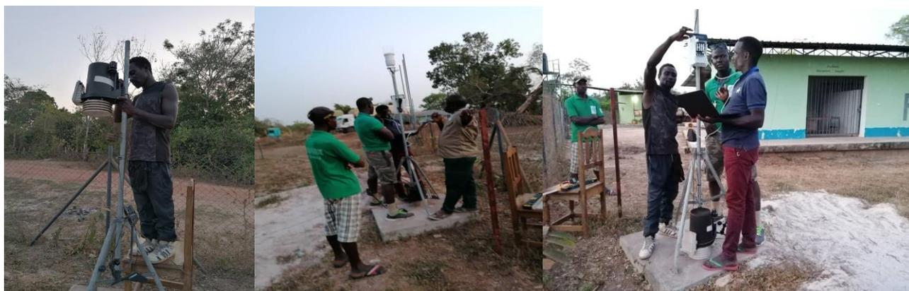
**Figura-10.** Montagem de estação meteorológica em São Domingos, ATMOS 41, registador Z6- 10709
