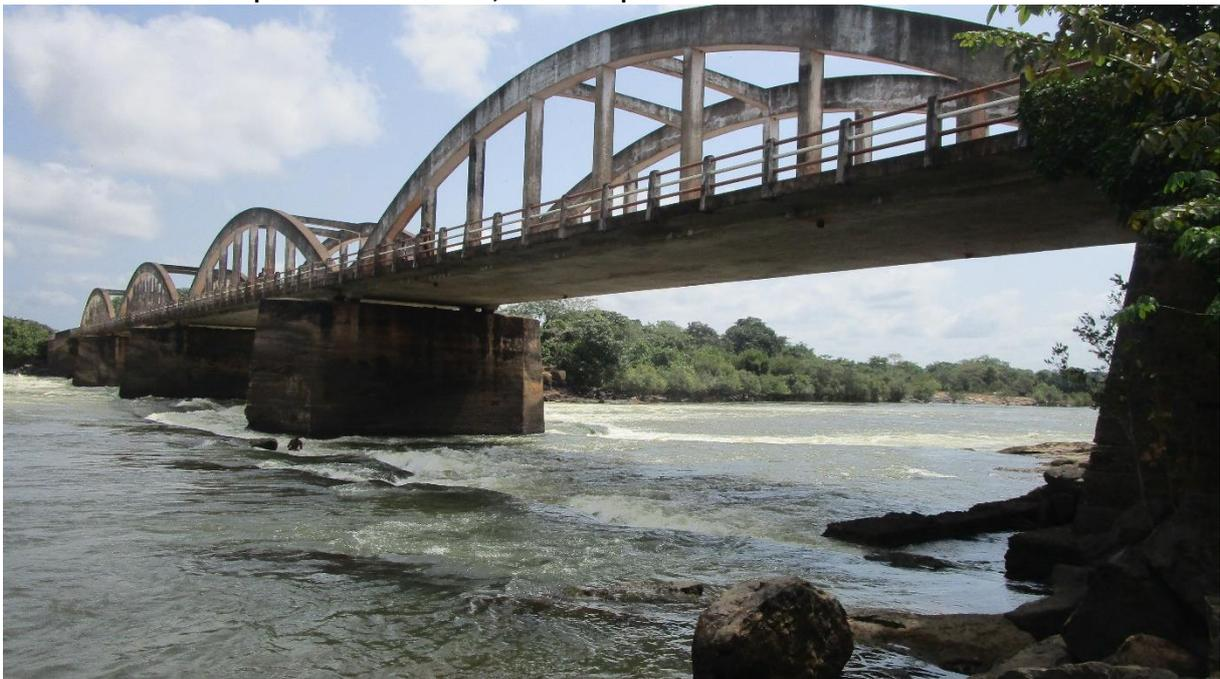
**Pont Geral Craveiro Lopes sur le Rio Corubal : installation d'un limnigraphe possible sur les piliers**
